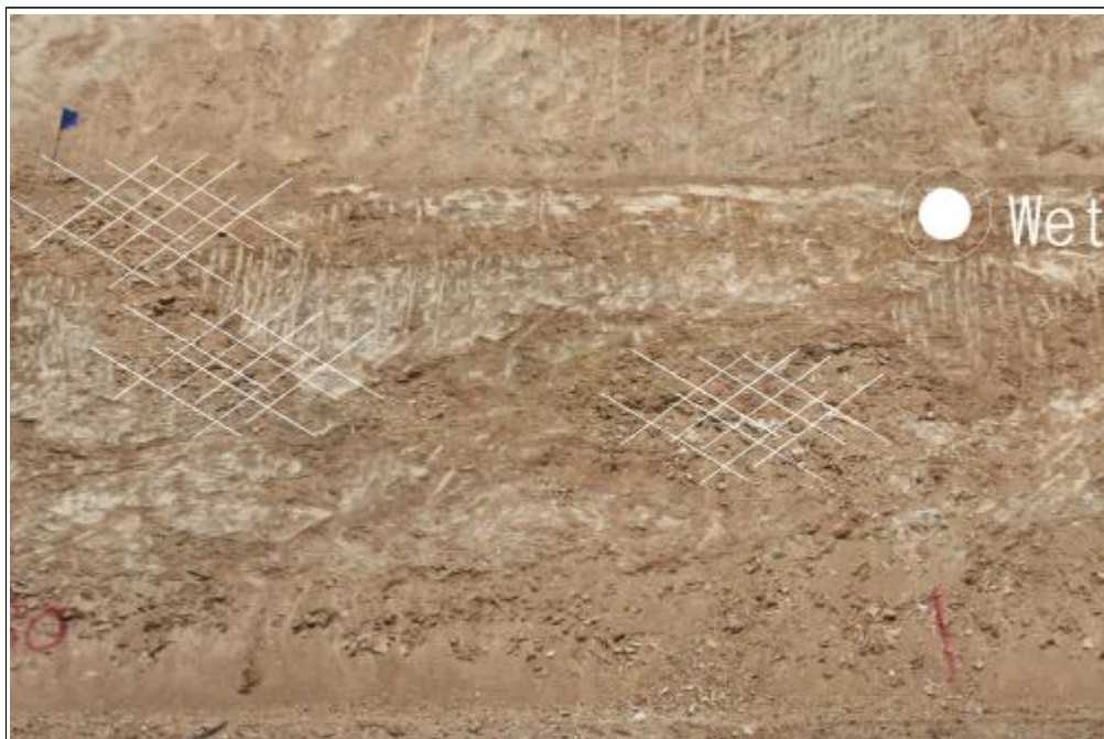
【그림 28】 D 영역 상세사진 (세편화된 암석 및 지하수 유출)
