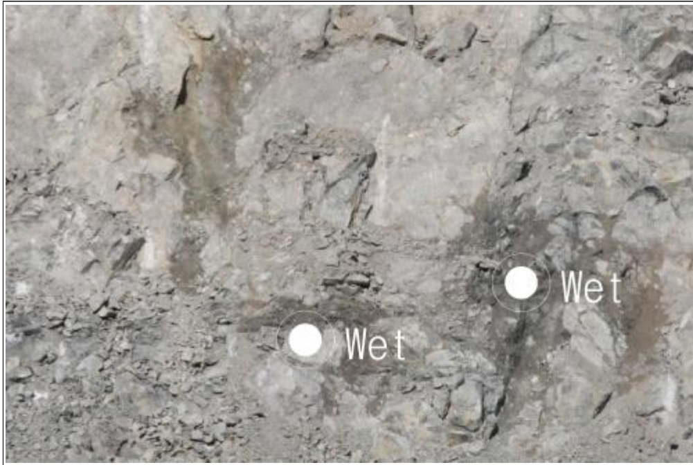
【그림 22】 C 영역 상세사진 (지하수 유출)
