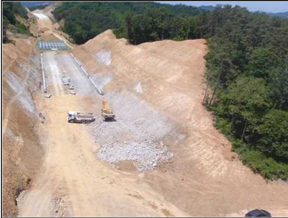
【그림 3】 깎기비탈면 시점부 측면 사진
