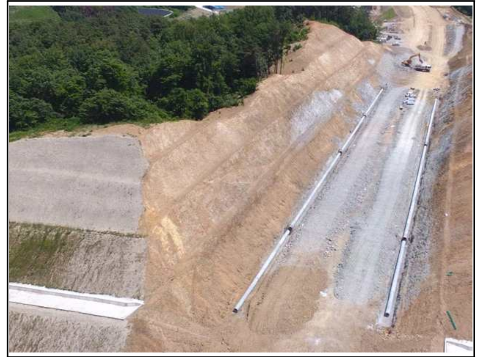
【그림 4】 깎기비탈면 종점부 측면 사진
